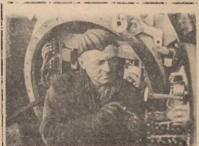
Владимир Степанович Фабизhevский — опытный электрослесарь участка МД и РЗО, 14 лет проработавший в коллективе, знакомится со схемой управления принципом работы и техническим обслуживанием вводимых в эксплуатацию на шахте комплексных распределительных высоковольтных устройств типа КРУВ-6, которые будут устанавливаться на гор. +, — 0 пласта дб и гор. +120 вост. дб, и которые постепенно вытеснят морально устаревшее оборудование.
