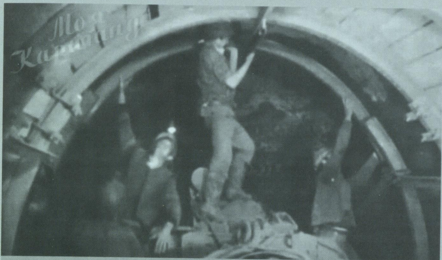
1980 год. Крепление горных выработок арочной металлической крепью.
